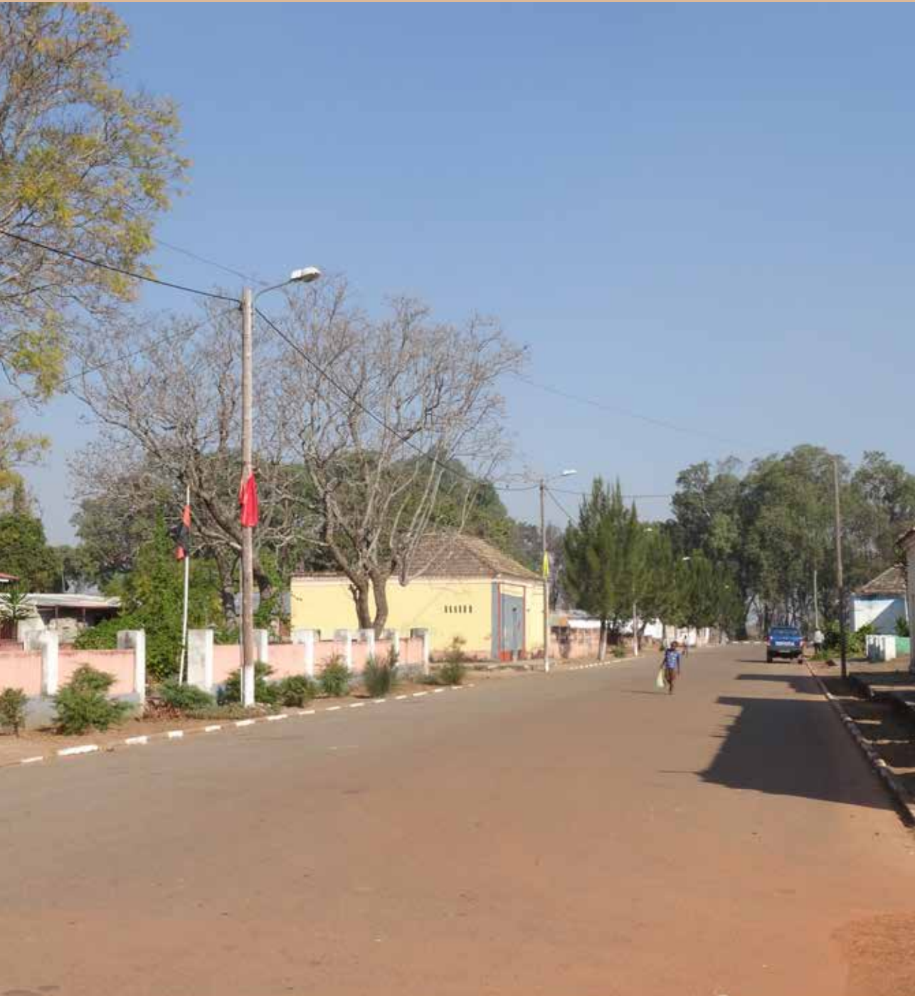
Rua na área central da Vila, com casas que datam da época colonial.
