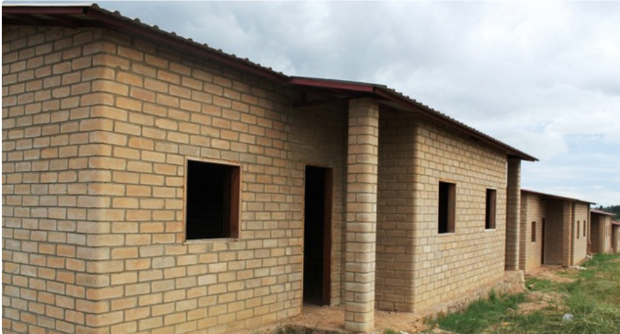
HUAMBO: TIPOLOGIA DAS CASAS
