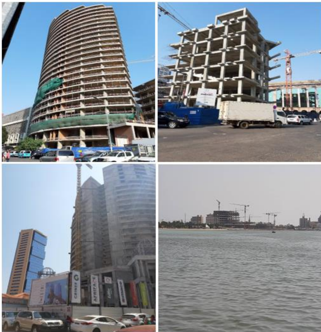
Fig. 12: Edifícios na marginal de Luanda em construção.
