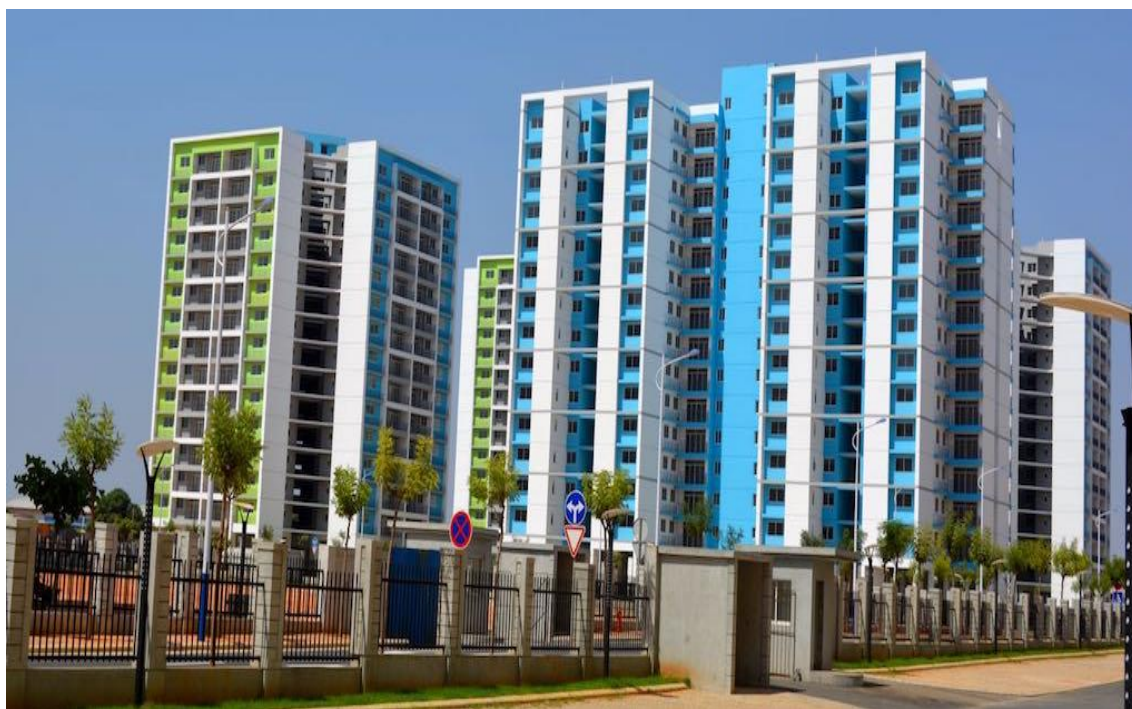
Fig. 22: Centralidade do Zango 0 – edifícios habitacionais.
