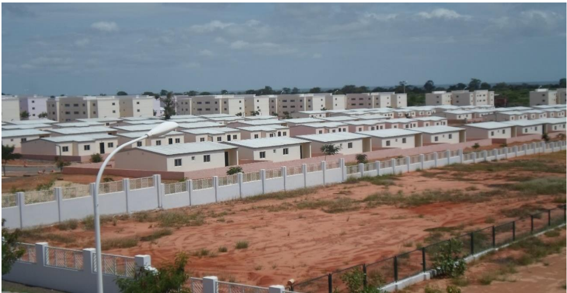
Fig. 23: Edifícios habitacionais na centralidade Zango 5 RED.
