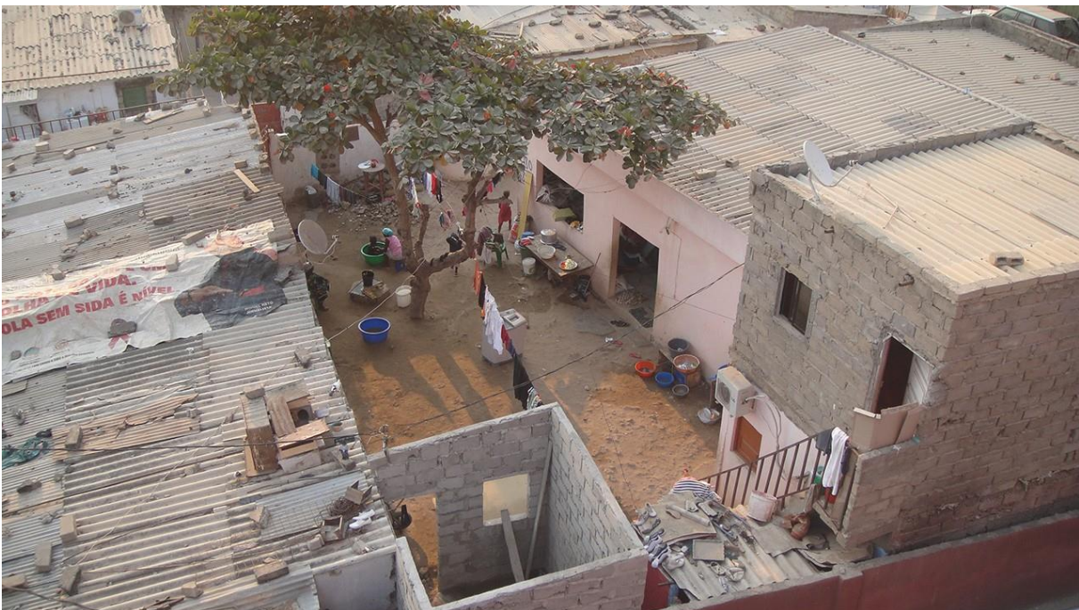
Fig. 139 | As coberturas são quase sempre em chapa de zinco por ser um material barato | Fonte: Chicala.org
