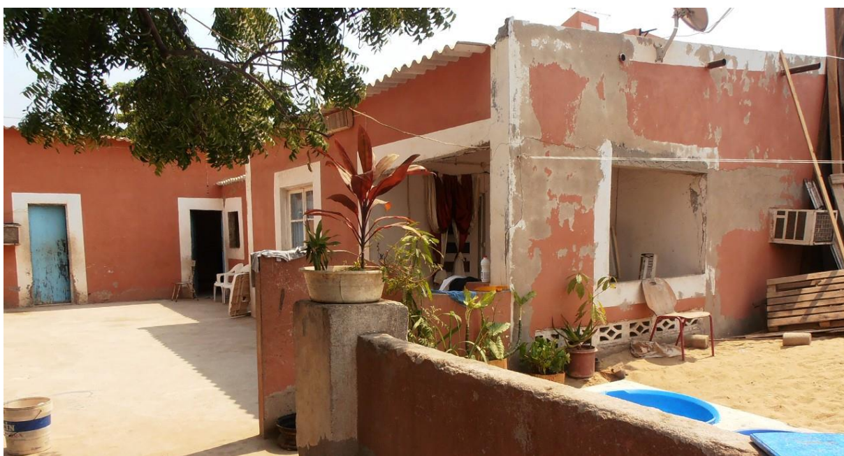
Fig. 126 | Repare-se nos tijolos furados usados na parte de baixo da habitação para facilitar a ventilação cruzada | fonte: Chicala.org
