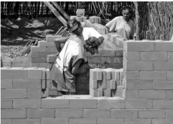
Fig. 42 | Aplicação dos blocos Fonte: www.arquiteturasdeterra.blogspot.pt
