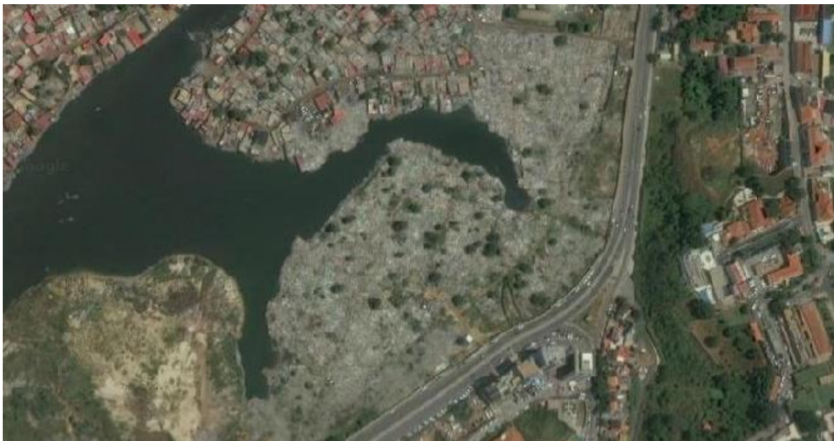
Fig. 142 | Zona demolida | fonte: googlemaps.com
