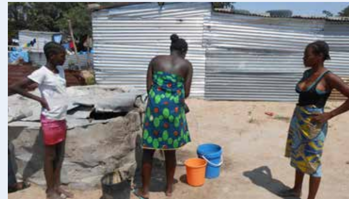
Um poço Ondungu protegido com uma tampa de chapa de zinco
