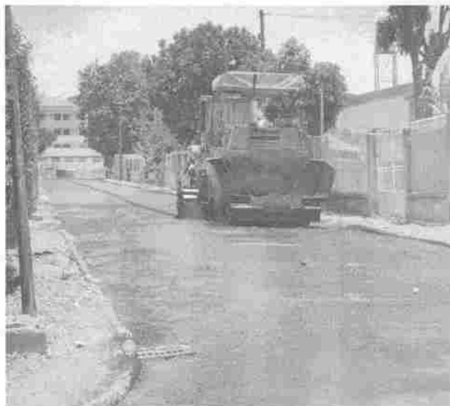
Por baixo dela deve existir uma camada sólida, preferencialmente rocha, da qual dependerá a sua vida futura. Não existindo uma boa e resistente fundação, a superfície acabará rachando-se.
