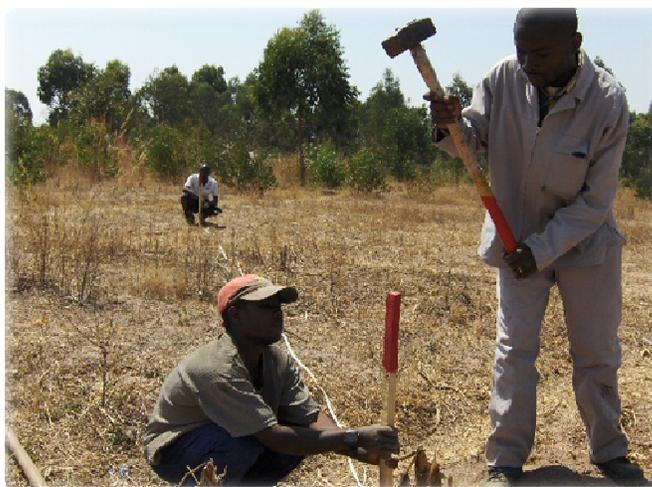
O loteamento é primeiro feito com estacas de madeira de aproximadamente 50 cm de comprimento. Elas são colocadas com uma maretta para dificultar a remoção ilegal. De preferência, serem pintadas as extremidades das estacas com cores que facilmente possam ser identificadas e diferenciadas as estradas dos lotes. Além de facilitar o 'reconhecimento' de estradas, as estacas pintadas são muito melhor visível no acto do alinhamento.
