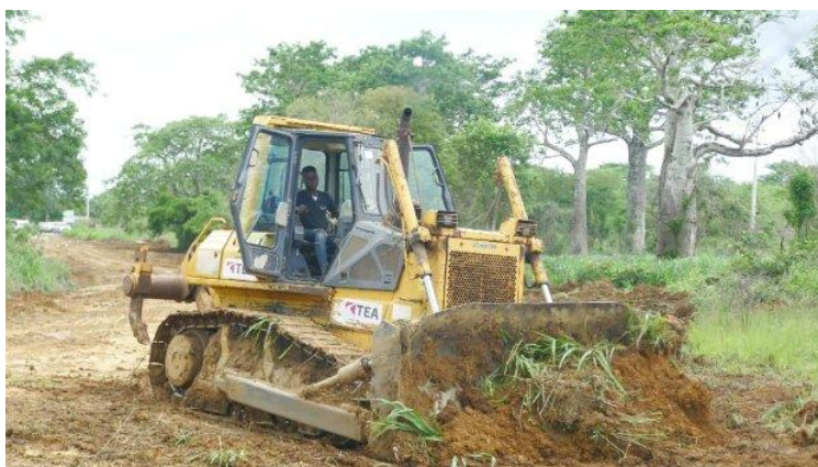
Obras de terraplanagem no Nzeto já arrancaram
