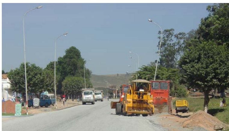
Reabilitação da estrada Caála-Huambo
