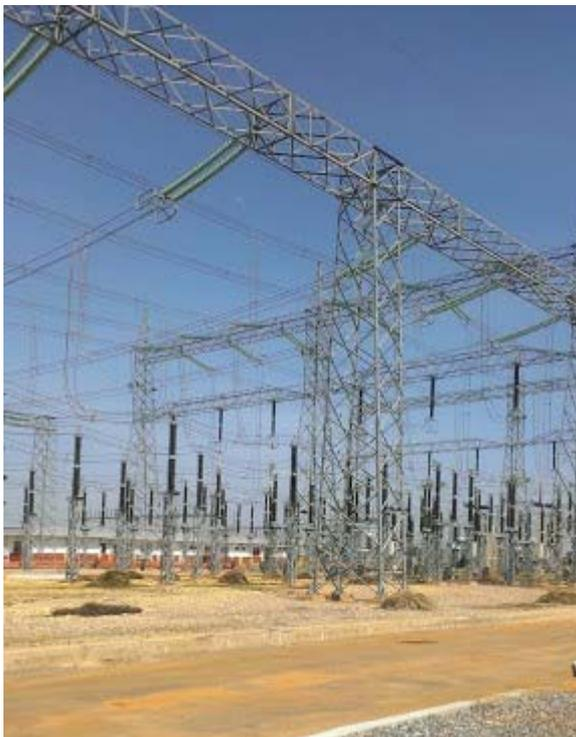
A energia em Alta Tensão que é produzida, é posteriormente encaminhada através de linhas de alta tensão aéreas até à subestação de Viana, a qual é transformada em Média tensão para ser distribuída, aos Postos de Transformação, para então a energia ser novamente transformada, para Baixa Tensão, para o consumidor final.
