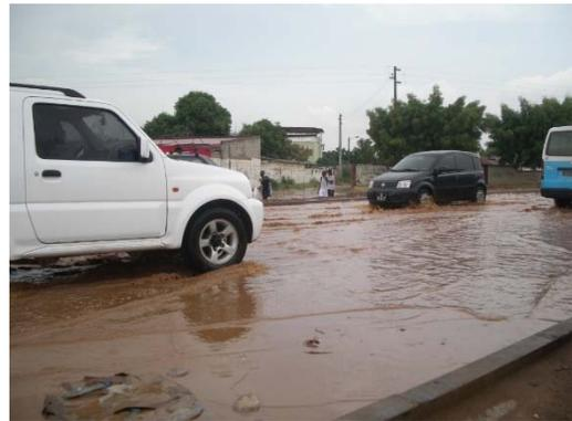
Figura 100 – Estado de conservação da rede viária. Ausência de sistemas de drenagem
