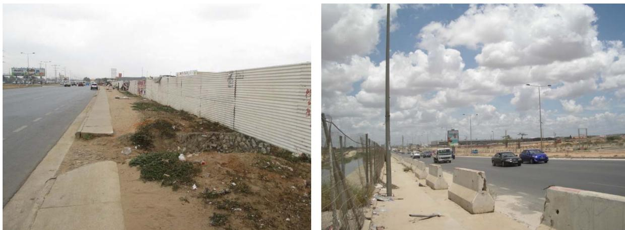
Figura 99: Estado de conservação da rede viária. Deficientes sistemas de drenagem e pavimentos em mau estado
